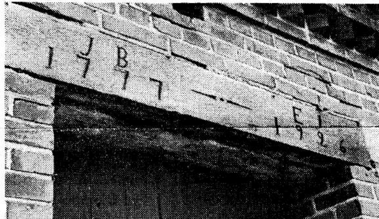
Døroverliggeren i udhuset med Jens (Jensen) Brasks initialer og aarstallet 1717. Udhuset blev nedbrudt i 1926, men bjælken indsattes
